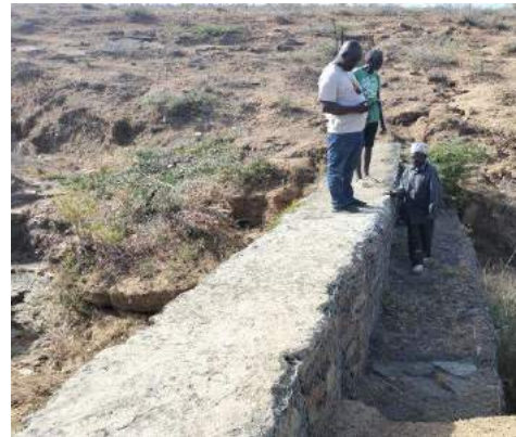
Mwachiga WRUA in Kwale
